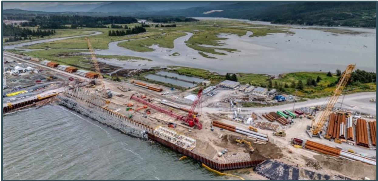
Figure 4 LNG Berth (AUGUST 2020)
