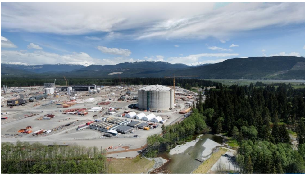
Figure 3.5 LNG Canada Project site (Q2 2021)
