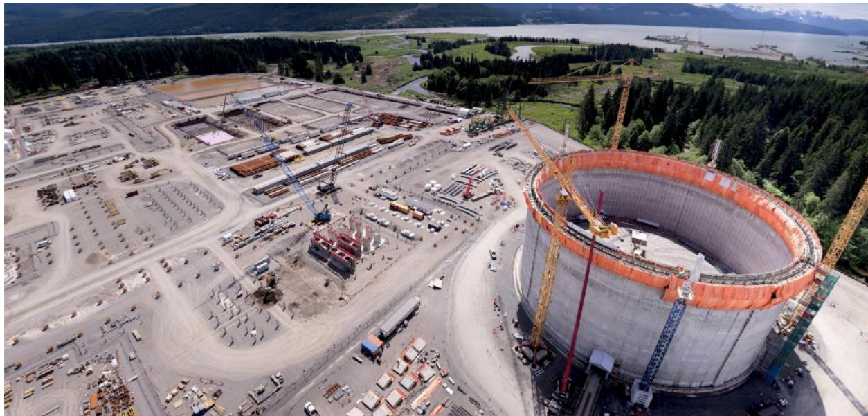
Figure 2 LNG Tank (2021 Q2)
